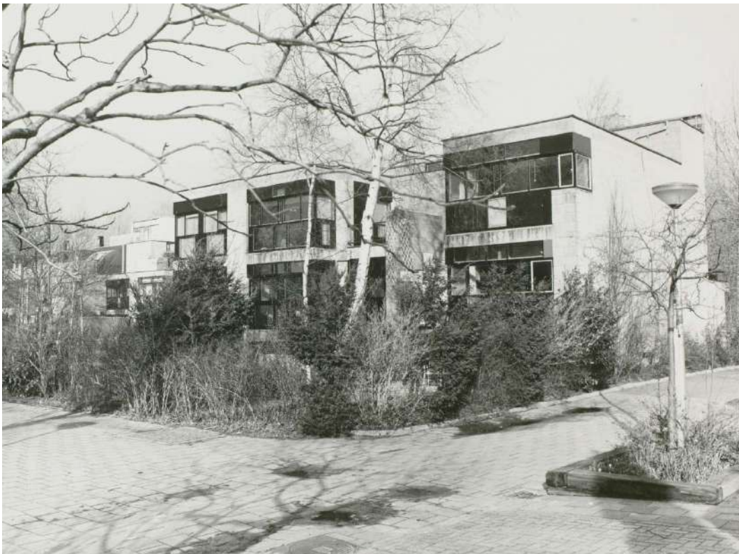
Figuur 9.3: Het gebruik van B2-betonblokken, geometrische vormen en vierkante volumes geven de woningen een 'blokkige' uitstraling (1990). Bron: Ton Kerklaan, Stadsarchief Delft.
