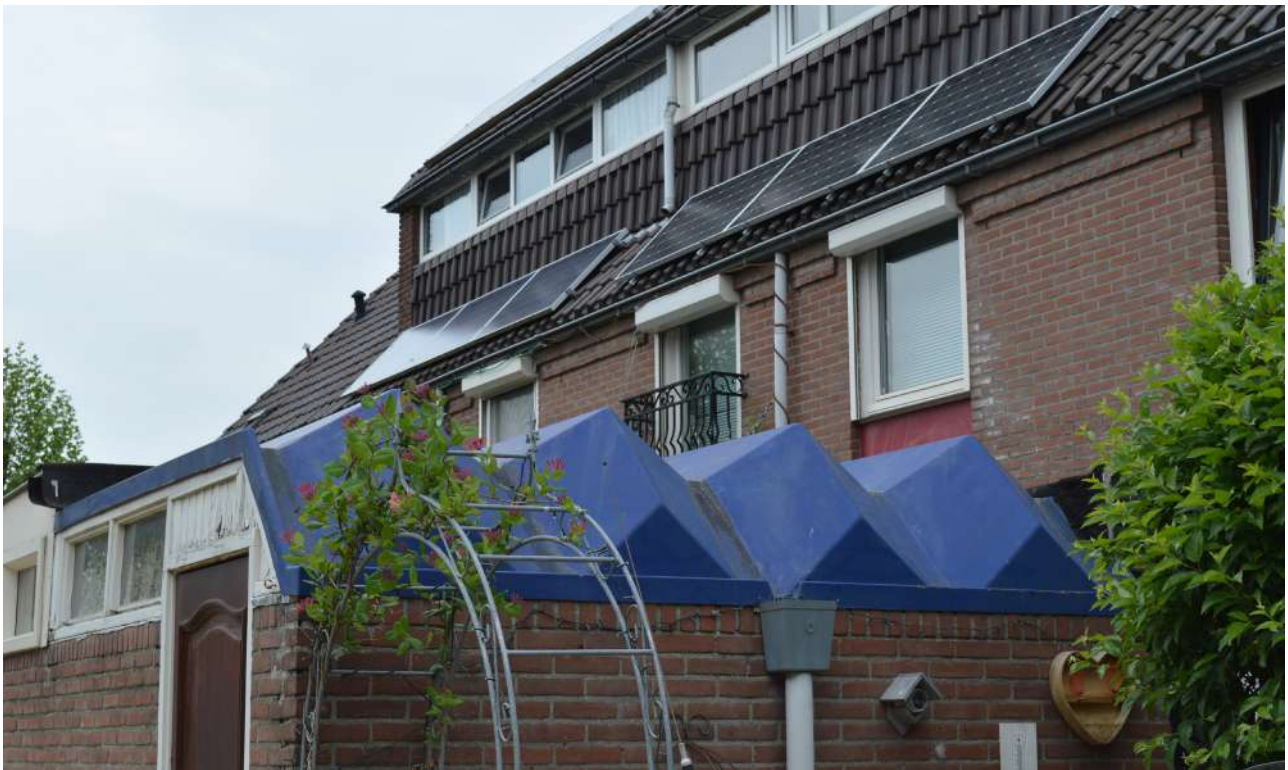
Figuur 8.3: De blauwe daken van de bergingsruimtes zijn een herkenbaar attribuut van Schoolwerf. Foto: L. Spoormans.
